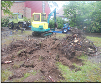
Links oben: Tiefer liegendes Wurzelwerk musste entfernt werden
